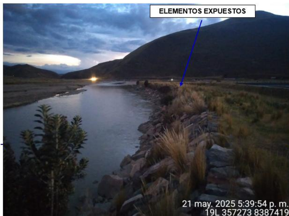
FIGURA N°02: TRAMO VULNERABLE Y SE EVIDENCIA DE LA EROSION DE LA RIBERA DEL MARGEN DERECHA, PONIENDO EN RIESGO LA PTAR DEL DISTRITO DE SAN ANTON, PROVINCIA DE AZANGARO - PUNO.
