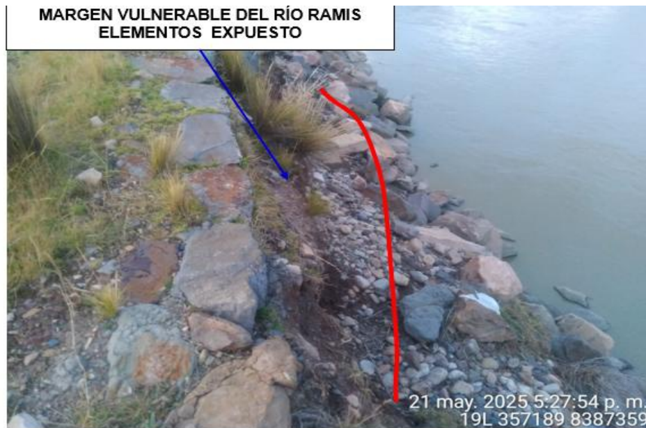
FIGURA N°01: TRAMO CRÍTICO EN EL RÍO RAMIS, DONDE SE EVIDENCIA LA EROSION DE LA RIBERA DEL RIO EN EL SECTOR ZONA URBANA , DISTRITO DE SAN ANTON, PROVINCIA DE AZANGARO - PUNO.
